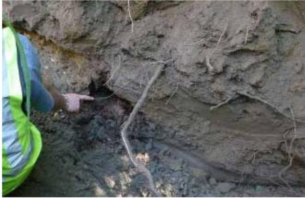
Photo 1 : Départ de galerie créée par une racine décomposée en pied de digue dans des matériaux limoneux
