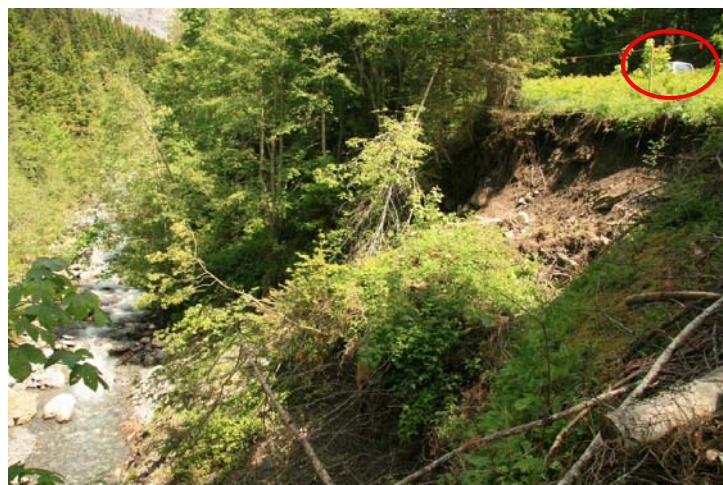
Secteur 2, 200 mètres en amont du pont. En haut à droite, on distingue le passage d'une voiture sur la route communale.
