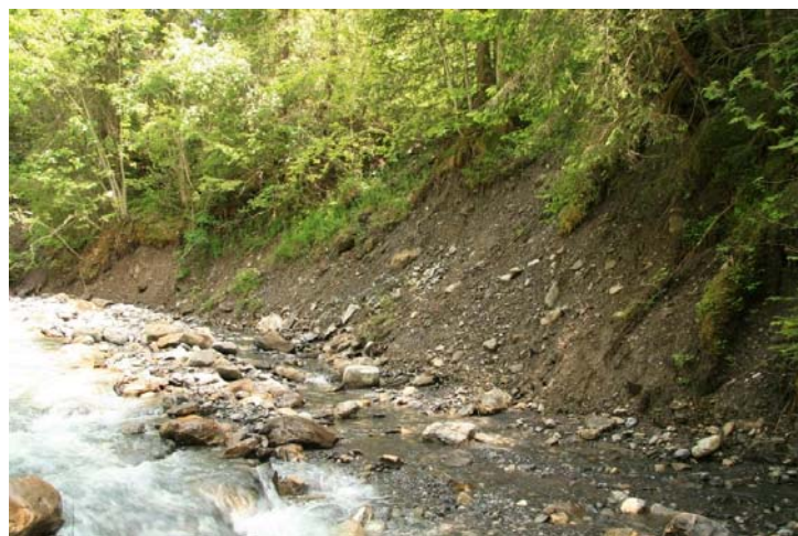
Secteur 3, 200 mètres en aval du pont
