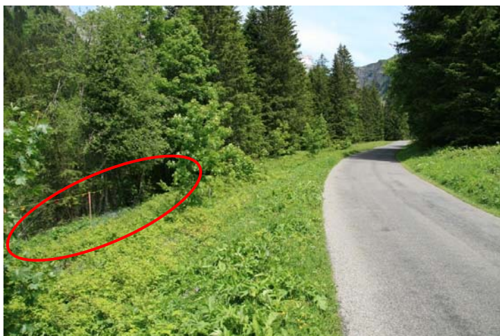
Route d'accès à Solalex. On peut constater la proximité du sommet du glissement avec celle-ci.
