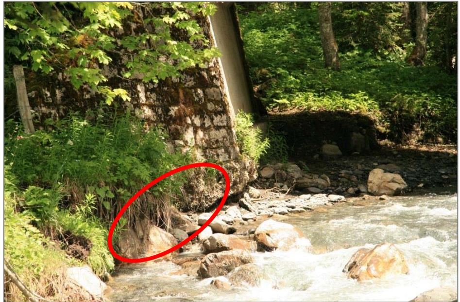
Fig. 1. Etat initial : incision sous la pile du pont en rive droite.
