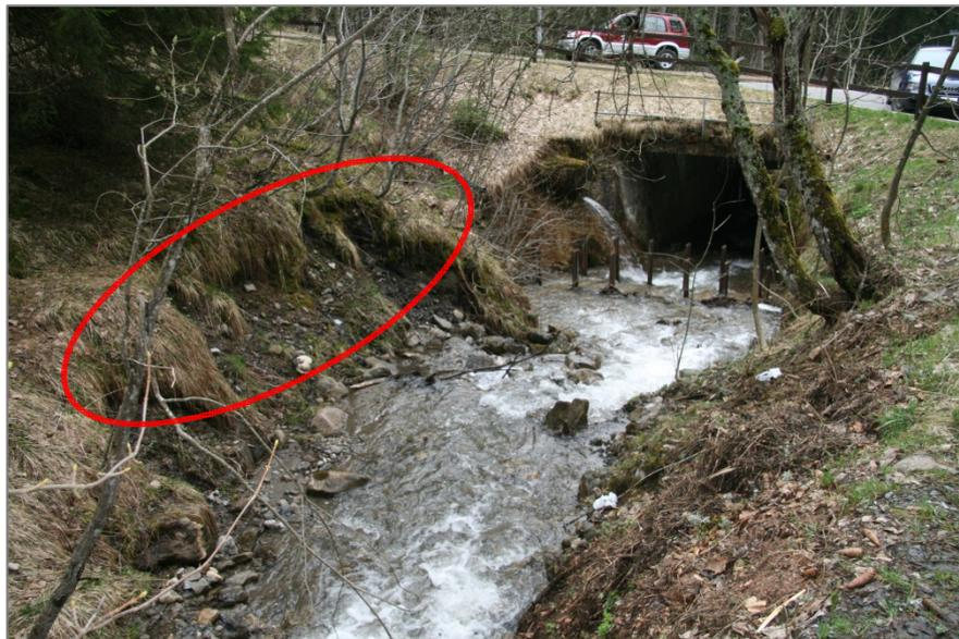
Fig. 1. Etat initial : alternance de glissements et de niches d'érosion en rive gauche.
