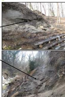
**Effondrement de la « casquette »** : environ 3-4 m<sup>3</sup> de matériaux qui se sont écroulés sur la partie supérieure du caisson recouvrant 3 lits de plants et plançons
