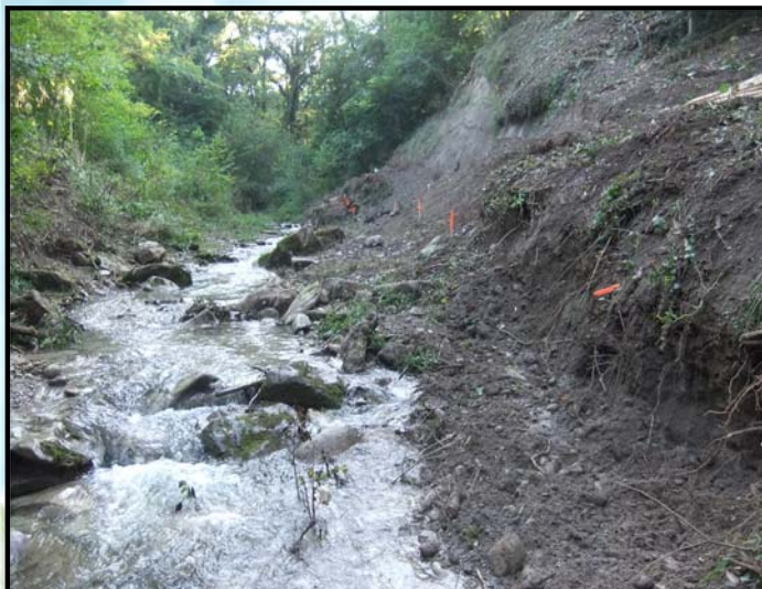
Zone érosion : fascine de saules + branches anti-sape + lits de plançons de saules derrière la fascine
