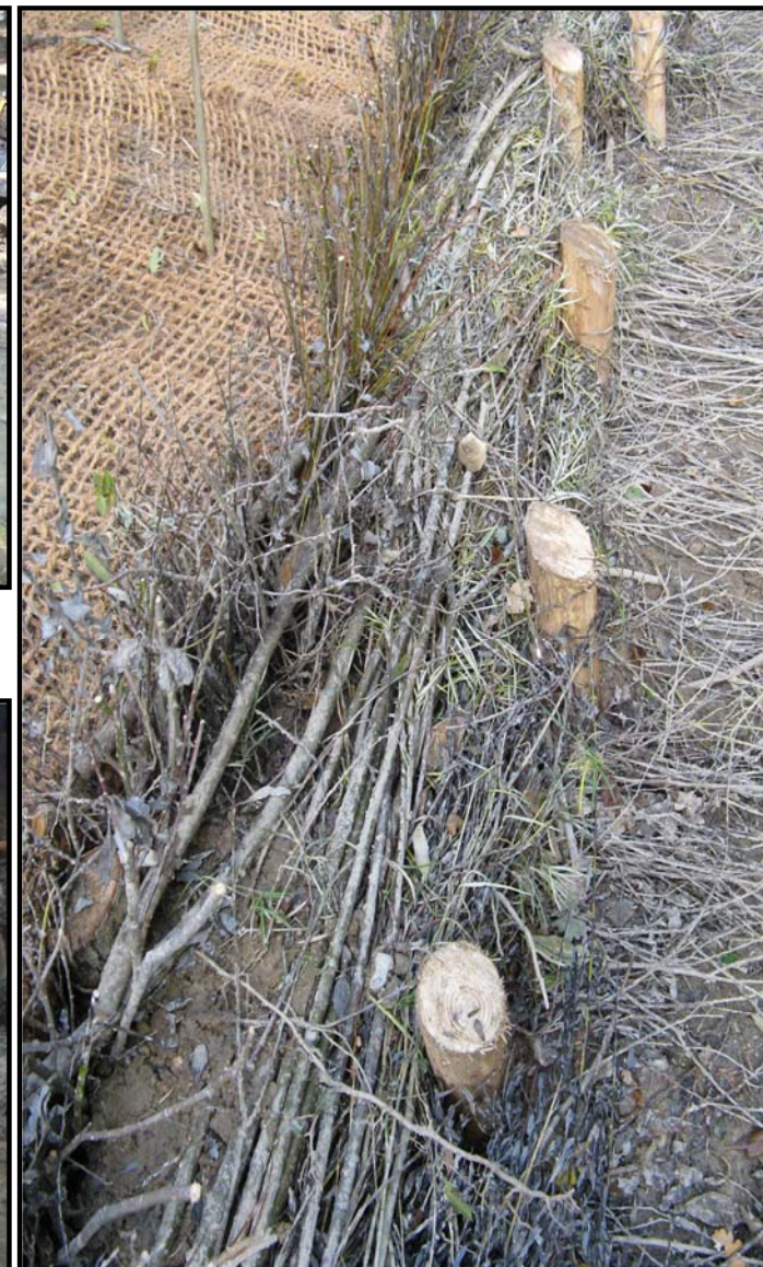
Zone érosion : fascine de saules + branches anti-sape + lits de plançons de saules derrière la fascine
