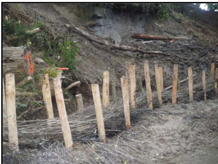
Fascine de saules : alternance pieux morts (Châtaignier) et vivants ( Salix alba + eleagnos ) – arrière fascine
