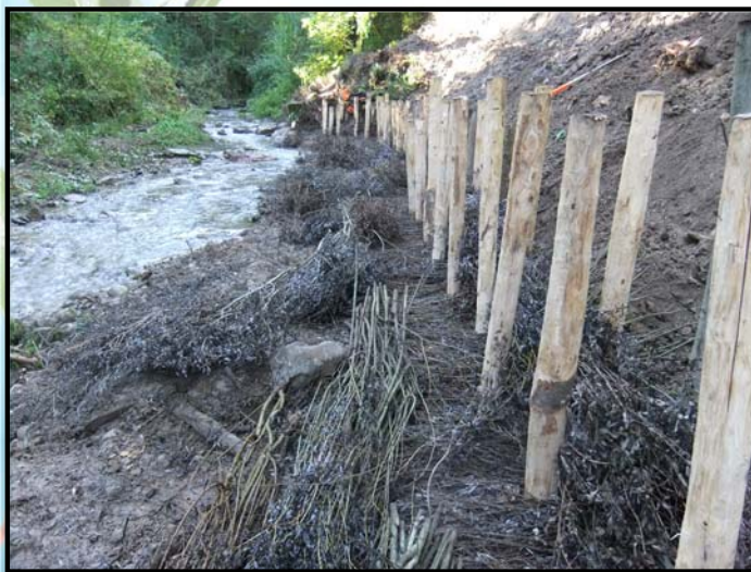
Fascine de saules : alternance pieux morts (Châtaignier) et vivants ( Salix alba + eleagnos ) – arrière fascine
