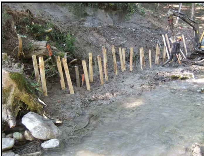
Zone érosion : fascine de saules + branches anti-sape + lits de plançons de saules derrière la fascine
