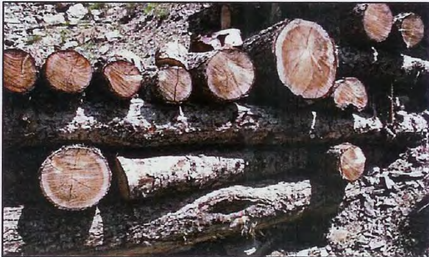
Figure 28 : parement bois parallèle aux longerons : fiche 05-07 (cliché RUOLT, 2005)
