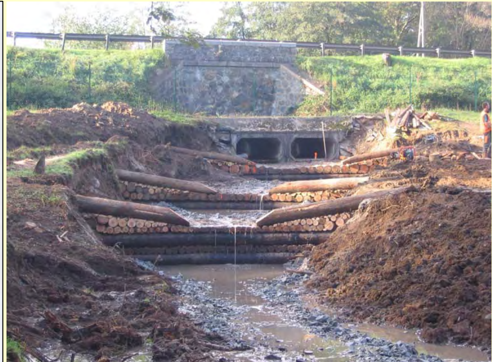
Figure 28 : parement bois parallèle aux longerons : fiche 05-07 (cliché RUOLT, 2005)
