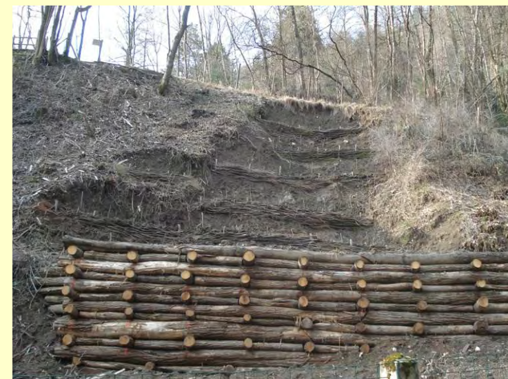
Cne La Terrasse (38) Parement en châtaignier avec bouches trous bois 2012 31
