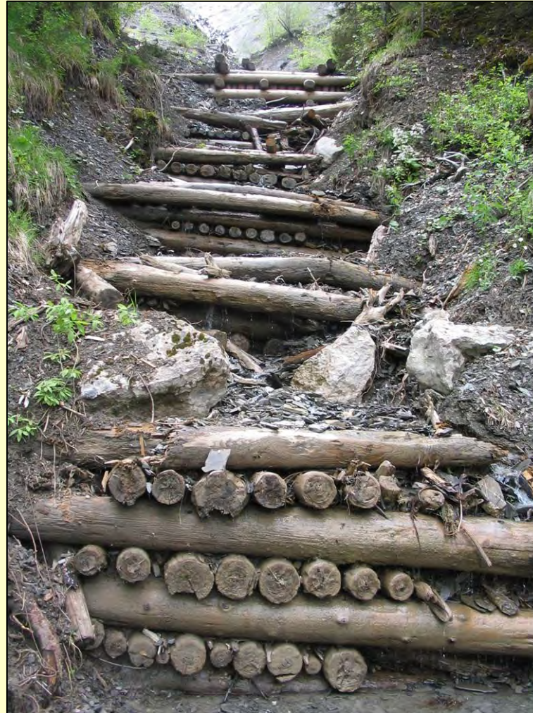
SD de Marnaz - (74) - état actuel de barrages de seuils construits en 1923
