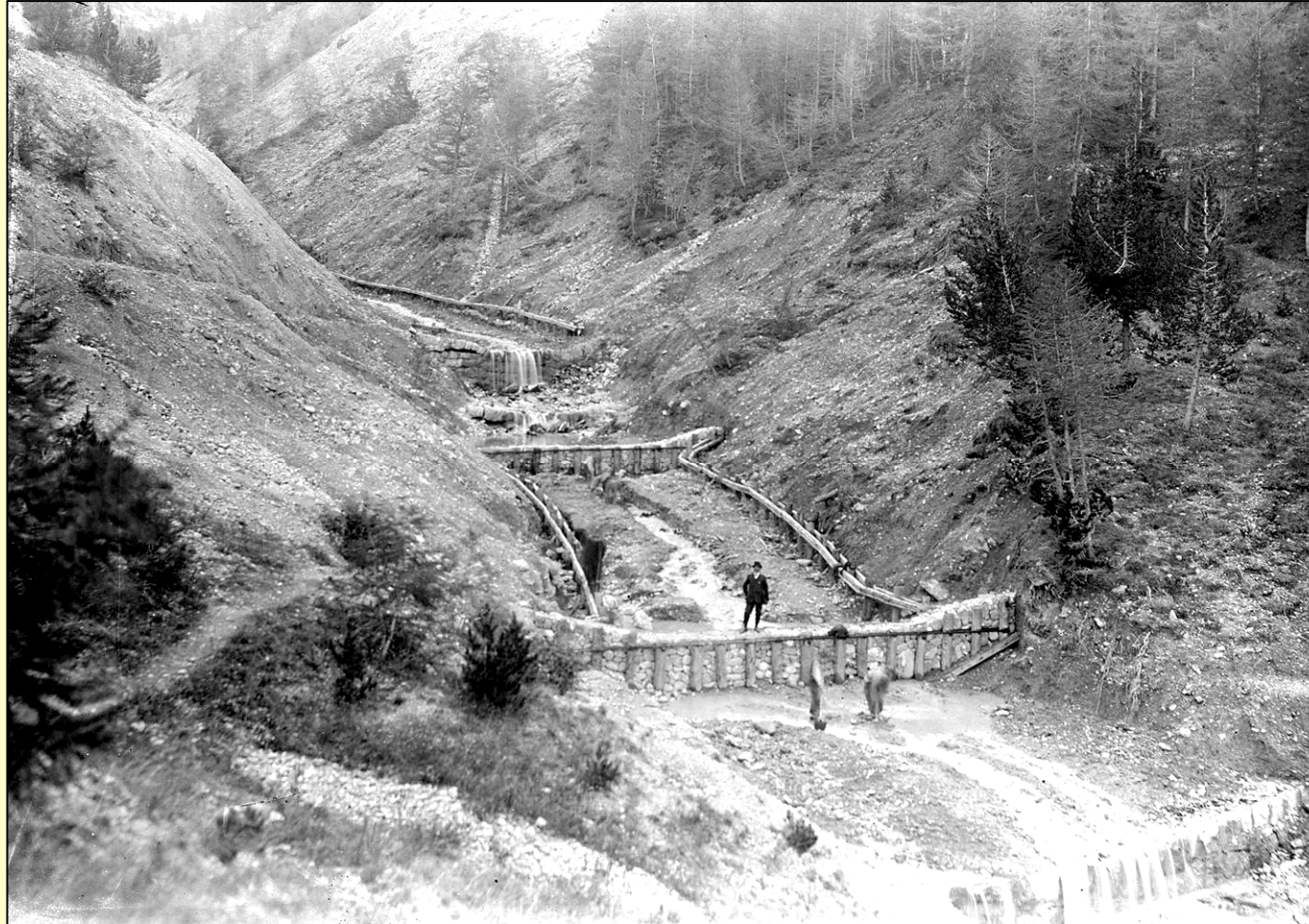
SD de Vars - torrent du Chagnon -barrages en pilotis - 1910
