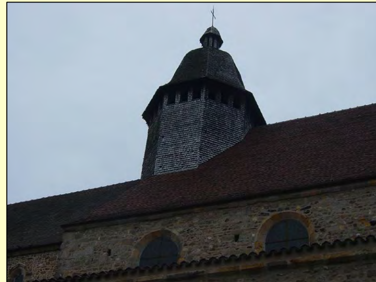
Bardeaux en châtaignier Clocher de l'église Evaux les Bains - 23
