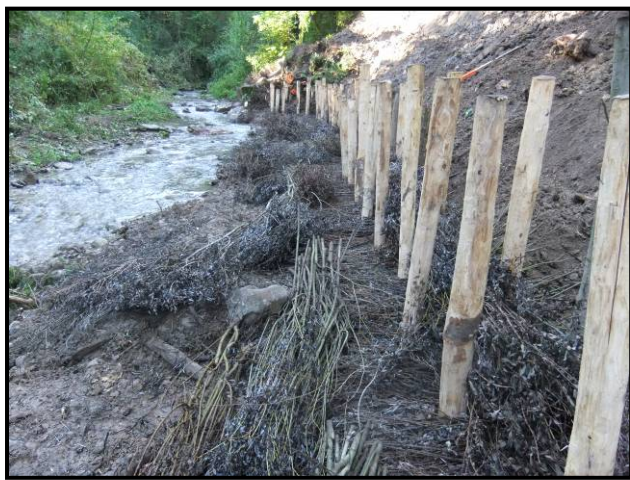
Fascine de saules : alternance pieux morts (Châtaignier) et vivants ( Salix alba ) – arrière fascine
