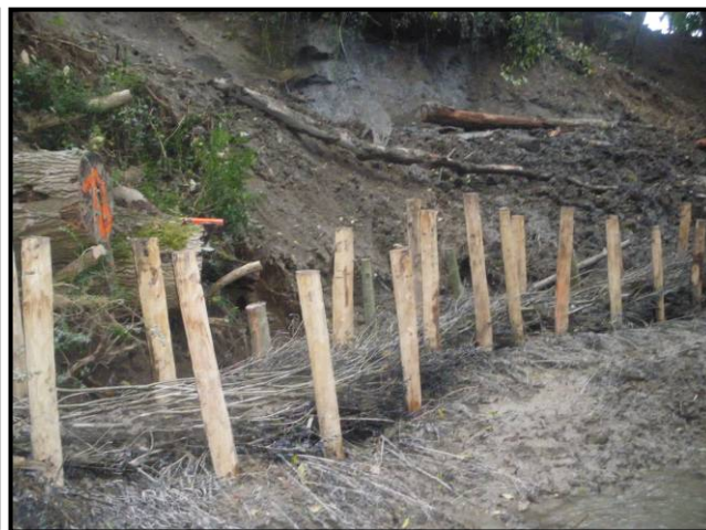
Fascine de saules : alternance pieux morts (Châtaignier) et vivants ( Salix alba ) – arrière fascine
