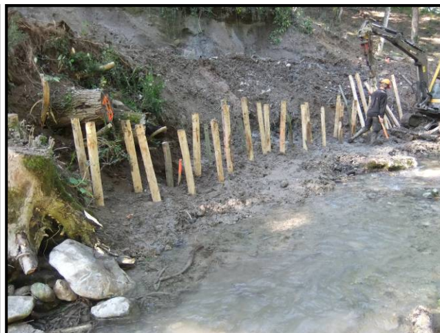
Zone érosion : fascine de saules + branches anti-sape + lits de plançons de saules derrière la fascine
