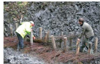
① Pose de fascine de saules sur la Petite Gryonne (Canton de Vaud - Suisse)
