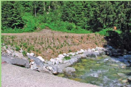
① Couches de branches à rejets et plantations sur le Bens : reprise végétative après 2 mois (Isère - France)
