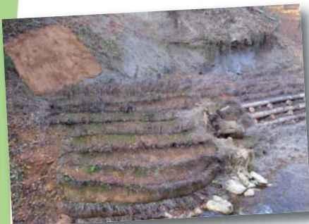
② Lits de plants et plançons et caisson végétalisé sur le Pamphiot (Haute-Savoie - France)
