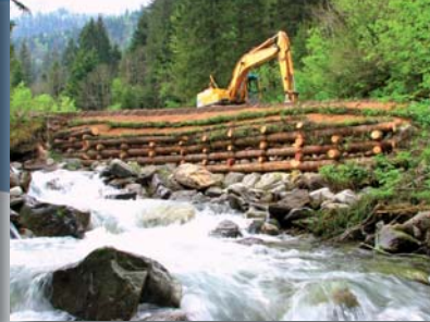
Finalisation du caisson végétalisé et des lits de plants et plançons sur le Bens (Isère - France)
