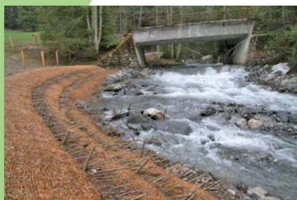
① Lits de plants et plançons sur l'Avançon d'Anzeindaz (Canton de Vaud - Suisse)
