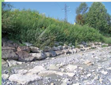
③ Reprise végétative suite à la végétalisation d'un enrochement sur l'Arve (Haute-Savoie - France)
