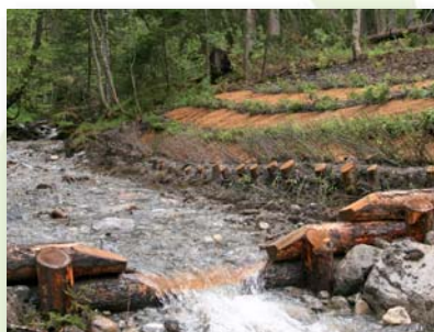
Fascine de saules surmontée de lits de plants et plançons sur la Petite Gryonne (Canton de Vaud - Suisse)
