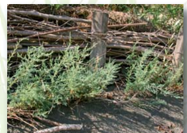
④ Fascine morte et lit de Myricaire ( Myricaria germanica ) sur l'Arve (Haute-Savoie - France)
