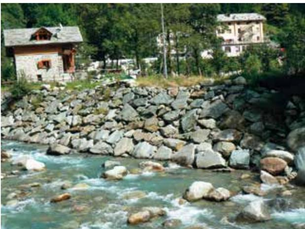
Fig. 20 - Protection de berge en enrochement sur un torrent de montagne.
