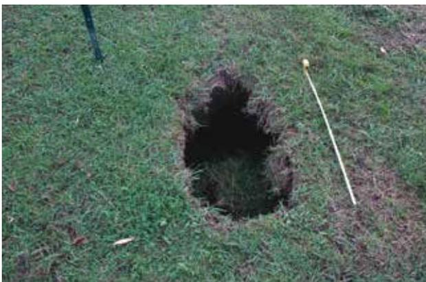
Fig. 5 - Effondrement en crête de digue suite à la décomposition d'une souche.
